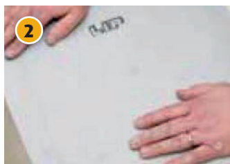
2. Klistra fast halva LIP Tätarket på den torra LIP VS 20 Ångspärren (för att lättare ta bort Puruskniven).
