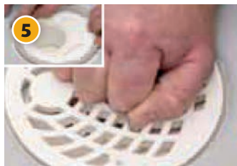
5. Sätt i klämringen med hjälp av golvbrunnssilen.
