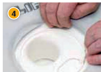
4. Se till att trycka fast tätarket och arbet bort luftblåsor. Forma tätarket efter golvbrunnen.
