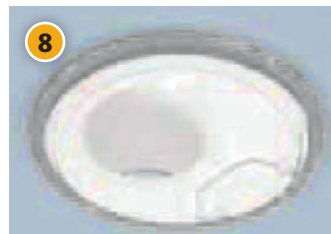
8. Färdigt resultat. Färdigstrykning med LIP VS 30. Behandlingen upprepas tills den totala materialåtgången uppgår till minst 1500 g/m 2
