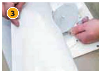
3. Skär upp hålet, vik upp den lösa halvan. Ta bort hållaren och montera fast resterande tätarket.
