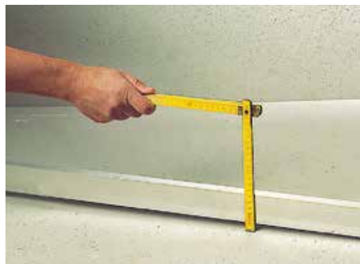
Kontrollera att inga svackor eller bulor förekommer innan tätskiktetsduken appliceras.
