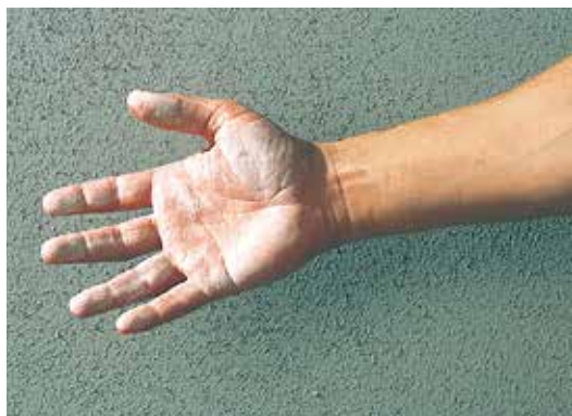
Underlaget ska vara rent och dammfritt.
