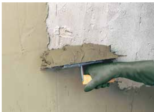
Ojämnheter spacklas ut med Sopro RS 462 eller Sopro USW 941.
