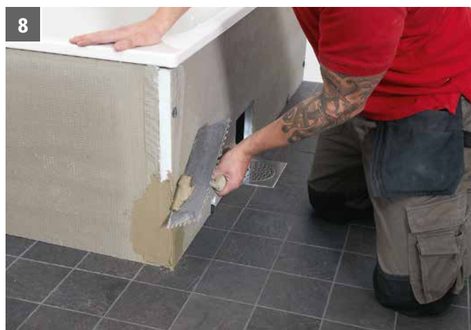
8 Använd en självhäftande armeringsväv till samtliga skarvar och ytterhörn. När skarvarna och vinklarna är armerade ska de spacklas över. Använd någon av fästmassorna Sopro FKM XL, Sopro's No. 1 eller Sopro SC 808.
