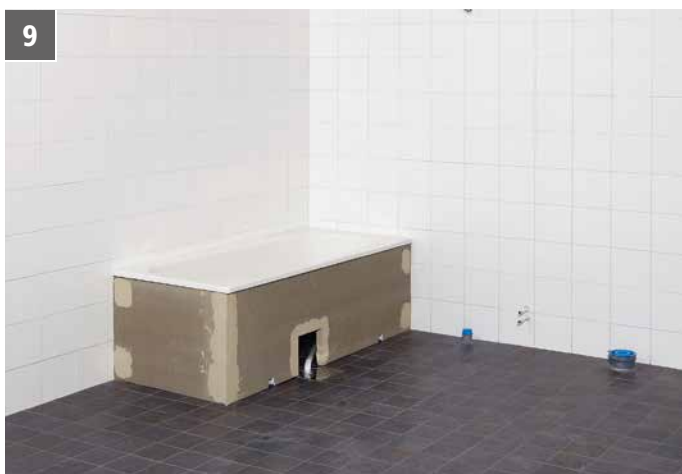
9 Låt spackelskiktet torka innan plattsättning kan påbörjas av inklädnaden. Torktiden varierar beroende på vilken fästmassa som använts.
