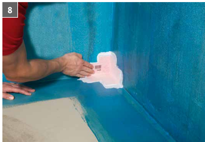
8 Montera innerhörnsmanschett i den blöta Sopro FDF 527. Säkerställ att inga veck eller blåsor uppstår på manschetten.
