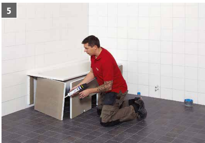
5 Limma vägglisten, ovkant av skivan och gaveln med monteringslimmet.
