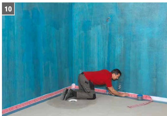
10 Montera bandet Sopro AEB 641 ifrån innerhörnet och utåt. Fortsätt på samma sätt runt hela golvet. Var noga med att inga hålkäl bildas. Säkerställ att inga veck eller blåsor uppstår på bandet.
