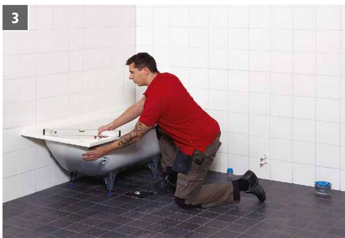
Ställ badkaret på plats och använd ett vattenpass för vågrätt inställning.
