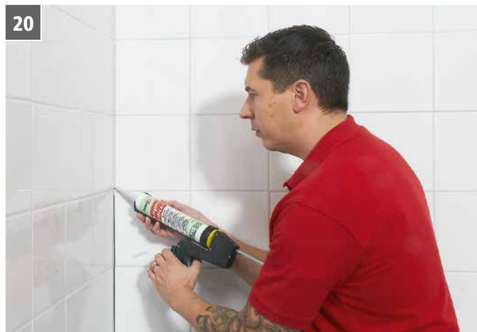
Vid de tillfällen där mjukfogning ska utföras ska det ske med Sopro Sanitär silikon. I takvinkeln ska inte fog av silikon användas eftersom den försvårar målningen.
