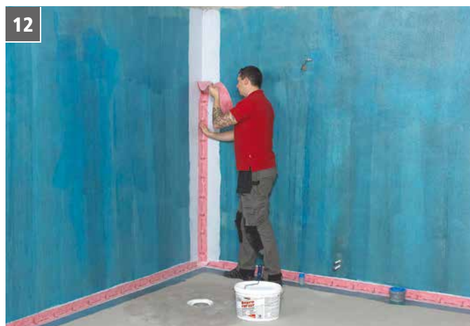
12 Montera bandet Sopro AEB 641 i innerhörnet. Säkerställ att inga veck eller blåsor uppstår på bandet.
