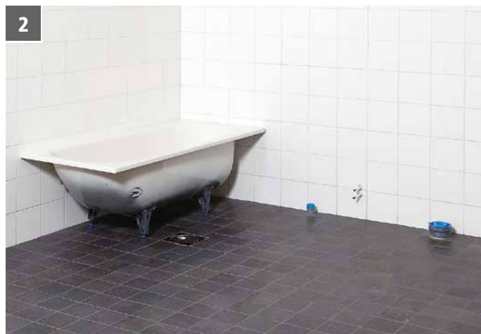
Följande bilder visar principen för hur ett badkar kan kläs in med formstabila lättviktsbyggskivor.
