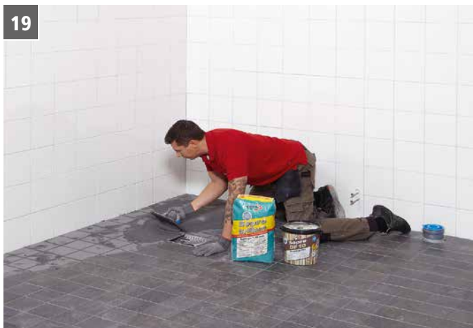
Golvplattorna fogas med någon av de smuts- och vattenavvisande fogmassorna Sopro Brillant, Sopro DF 10 eller Sopro FL plus.
