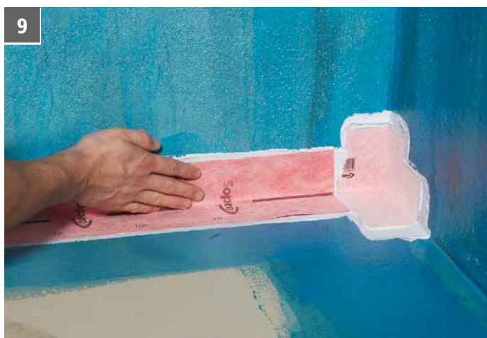
9 Pensla eller rolla Sopro FDF 527 över innerhörnet och vidare i golv-/väggvinkeln för att kunna montera bandet Sopro AEB 641 i golv-/väggvinkeln. Bandet ska överlappa innerhörnet med minst 5 cm.
