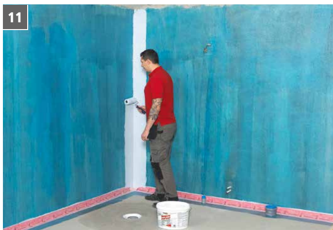
11 Rolla Sopro FDF 527 i innerhörnet.
