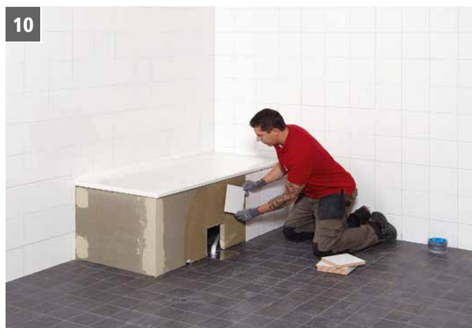
10 Plattor sätts med någon av fästmassorna Sopro FKM XL, Sopro's No. 1 eller Sopro SC 808 och fogas med den smuts- och vattenavvisande fogmassan Sopro Saphir® 5 eller Sopro DF 10.
