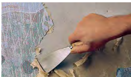
Befintliga ytskikt skall avlägsnas.
