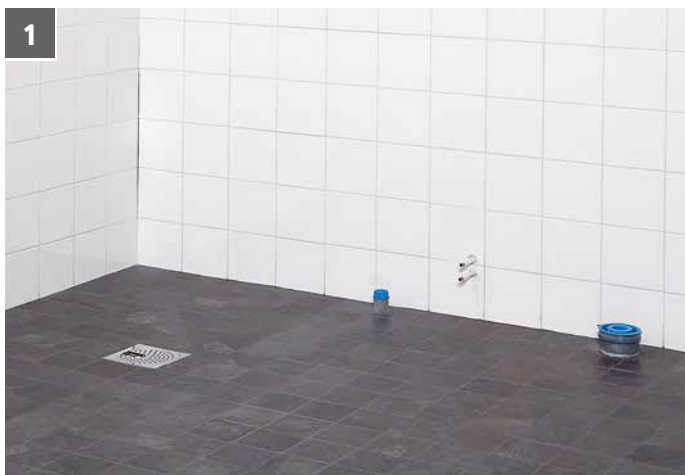
Nu är badrummet klart för inbyggnad av badkar samt montering av wc, handfat etc
