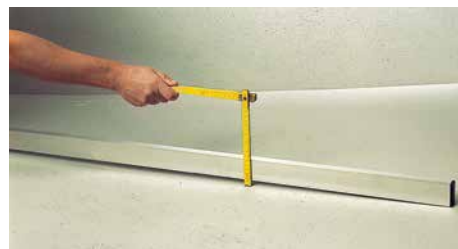
Kontrollera att inga svackor eller bulor förekommer innan tätskiktsduken appliceras.
