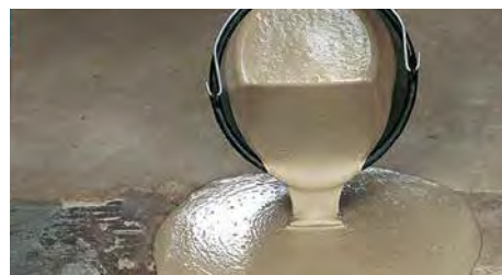
Avjämning utförs med Sopro VS 582.
