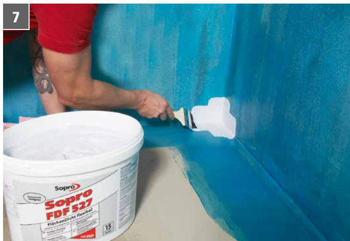
7 Rolla eller pensla tätskiktet Sopro FDF 527 i innerhörnet.
