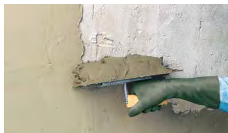
Underlaget förbehandlas med Sopro GD 749 och ojämnheter spacklas ut med Sopro RAM 3 eller Sopro USW 941.
