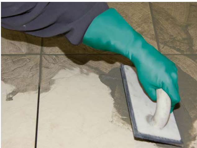
Fogning utförs med t.ex. Sopro DF 10®, Sopro FL plus eller Sopro FlexFuge FL när lägningsbruket är klart för att beträdas och fogas.
