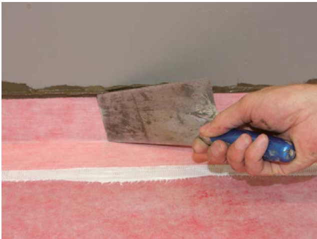
Tryck fast med en slev. Ta bort överflödig fästmassa från väggen eller avstryk den mot väggen.
