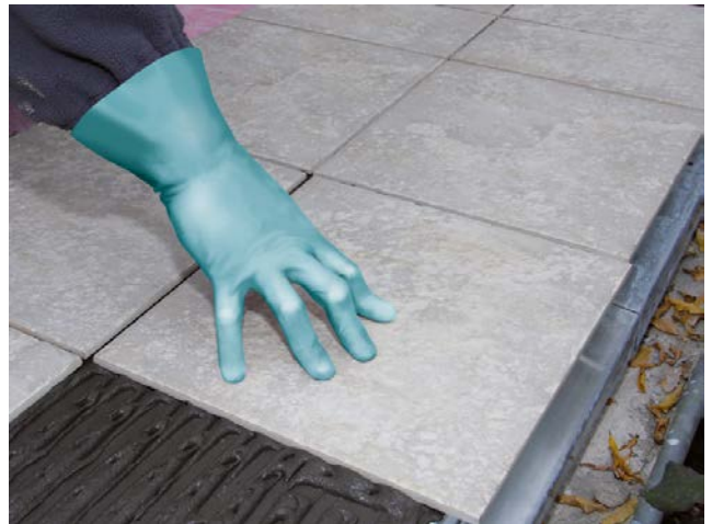
Keramiska plattor kan sedan läggas direkt på Sopro AEB® plus 639 utan långa väntetider med hjälp av Sopro megaFlex S2 turbo
