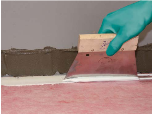
Där AEB 639 angränsar mot väggen appliceras Racofix 818 / FDK 415/ FDK 1180 1K.
