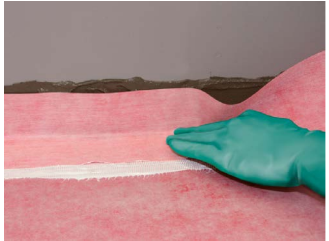
Lägg in den böjda tätremsan Sopro AEB® i den blöta limbädden ...
