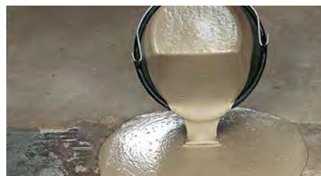
Avjämning utförs med Sopro VS 582.
