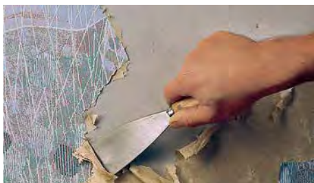
Befintliga ytskikt skall avlägsnas.
