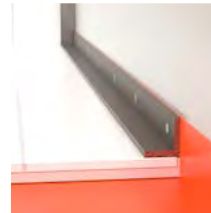
FIGUR 10. Mekanisk förankring av tätskikt (typ 2).
