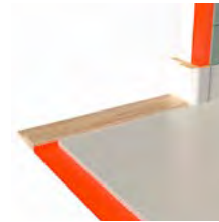
FIGUR 9. Avslut av tätskikt.
