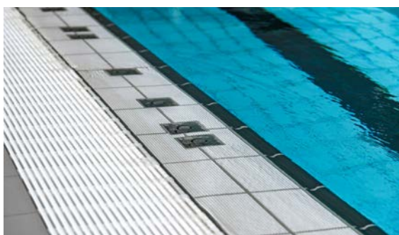
Bild 4. Rännor som kan beträddas måste täckas med galler som är avsedda för ändamålet. Öppningar i gallret får vara max 8 mm breda. Avstånd mellan gallerkant och kant på skvalpräanna får vara max 8 mm totalt.
