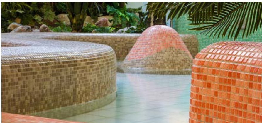
Bild 23. Skurna plattor ska dövas för att undvika vassa hörn och kanter. Runda former är att föredra. Detta för att undvika skaderisk vid kroppskontakt.
