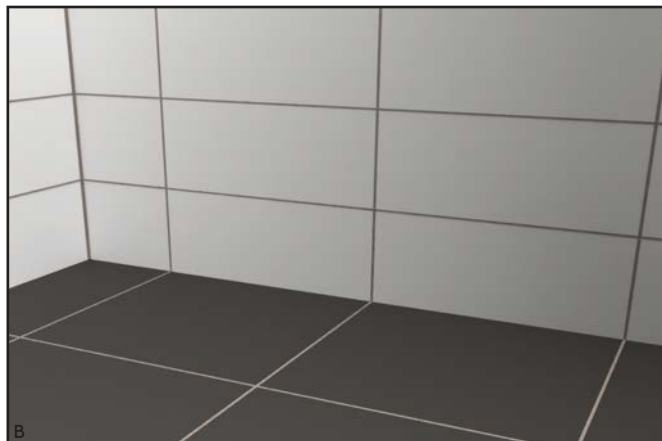
FIGUR 10 B. Fogar på golv och vägg är linjerade. Plattor på golv och vägg måste då vara modulanpassade.
