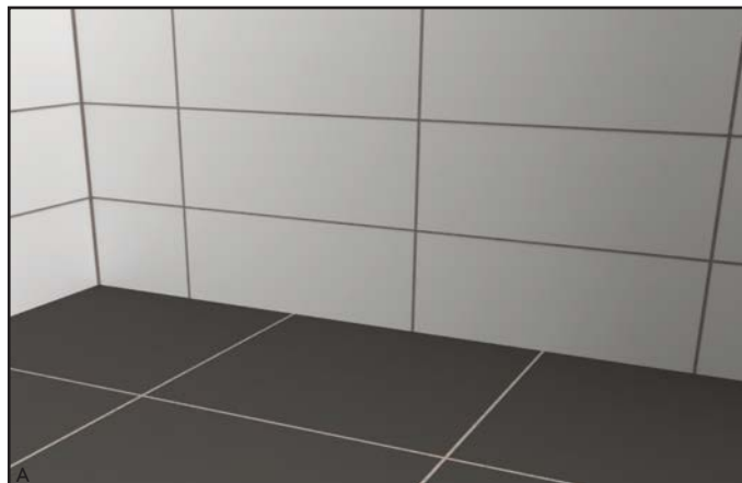
FIGUR 10 A. Fogar på golv och vägg avviker markant.
