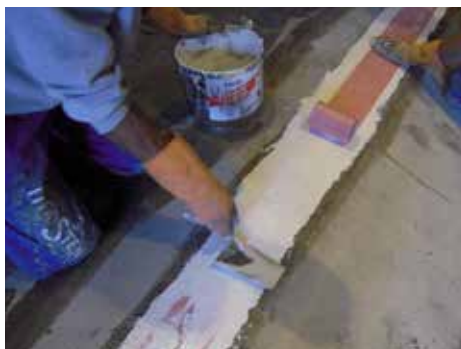
Vattentätning av en expansionsfog med två lager av förseglningsband inbakat i Sopro PU-FD 1570/1571 ytförsegling som sandas med kvartssand för vidhäftning med Sopro TDS 823 / Sopro ZR Turbo Maxx 618.
