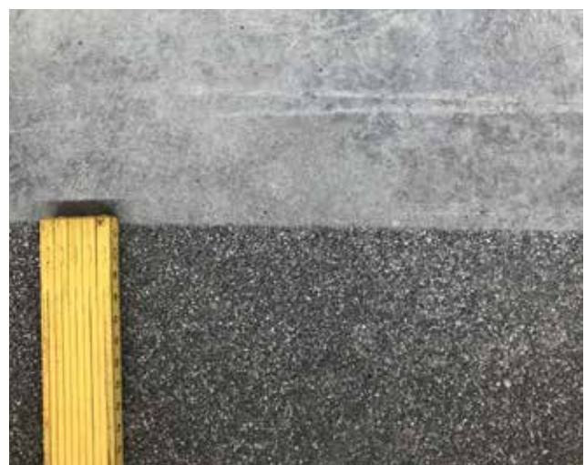
Anläggningsbetong före och efter vattenblästring.
