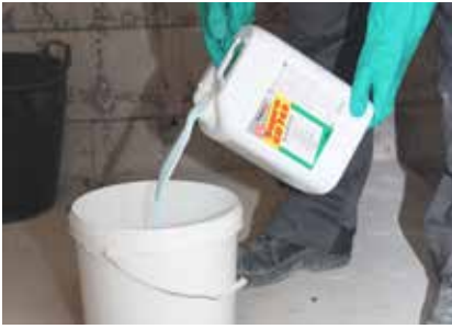
Häll upp primer Sopro GD 749 oförtunnad i en hink.
