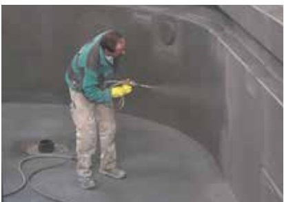
Sopro TDS 823 kan även appliceras med sprayteknik.
