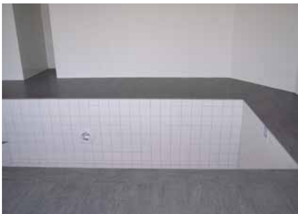
Privat pool Bjällerup: Pool bestående av gjuten betongbotten, väggar av Lecablock murade och putsade med nätat B-bruk ca 20 mm. Ingen avrinning. Tätad med system Sopro DSF 623.
