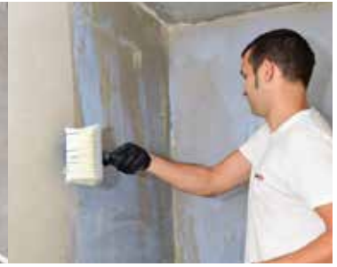
Prima samtliga ytor med t.ex. en roller eller kalkkvast. Produkten är även sprutbar.
