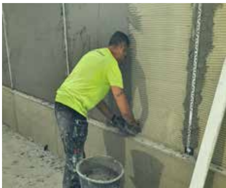
Banor monterade i Sopro's No. 1 för putsning/ upprättning av vägg med Sopro SBP 474.
