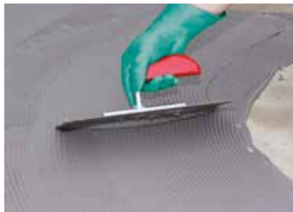
Applicera Sopro TDS 823 med en tandad spackel (4 mm) på det fuktade resp. primade underlaget.
