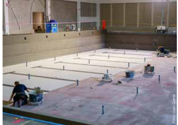
Plattsättning utförs enligt dubbelklistningsmetoden.
