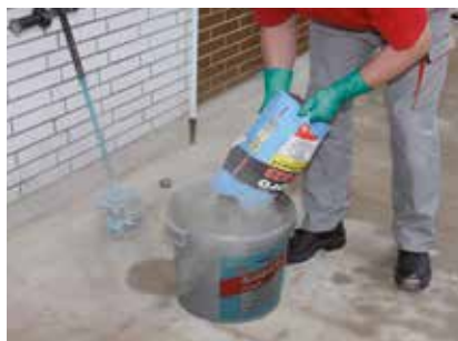
Tillsätt Sopro TDS 823 pulverkomponent.
