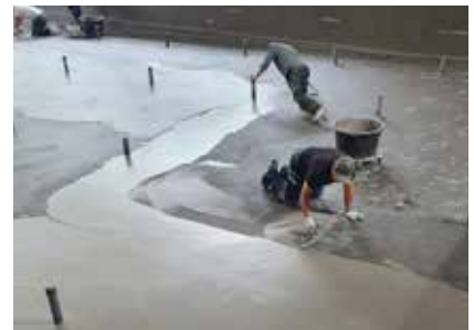
Släta ut Sopro TDS 823 med baksidan av tandspackeln.
