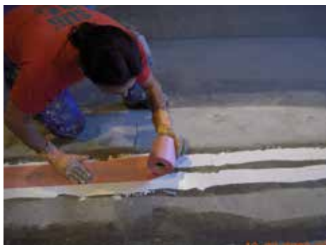
Vattentätning av en expansionsfog med två lager av förseglningsband inbakat i Sopro PU-FD 1570/1571 ytförsegling som sandas med kvartssand för vidhäftning med Sopro TDS 823 / Sopro ZR Turbo Maxx 618.
