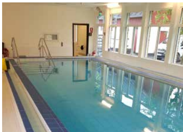
Rehab pool Habo Gård: Helgjuten inomhuspool i betong, som renoverades 2014. Tätad med system Sopro DSF 623, avrinning enligt kanträna "Finland".
