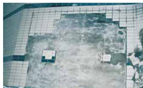
Bilderna ovan visar läckage vid lamphus, som orsakat plattsläpp långt ut på väggen samt plattsläpp i botten av poolen orsakad av vatteninträning bakom tätskiktet.
