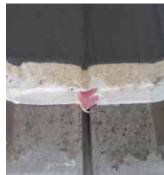
Vattentätning av en expansionsfog med två lager av förseglningsband inbakat i Sopro PU-FD 1570/1571 ytförsegling som sandas med kvartssand för vidhäftning med Sopro TDS 823 / Sopro ZR Turbo Maxx 618.
