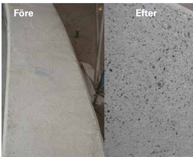
Högtryckstvättning av betongytor.
