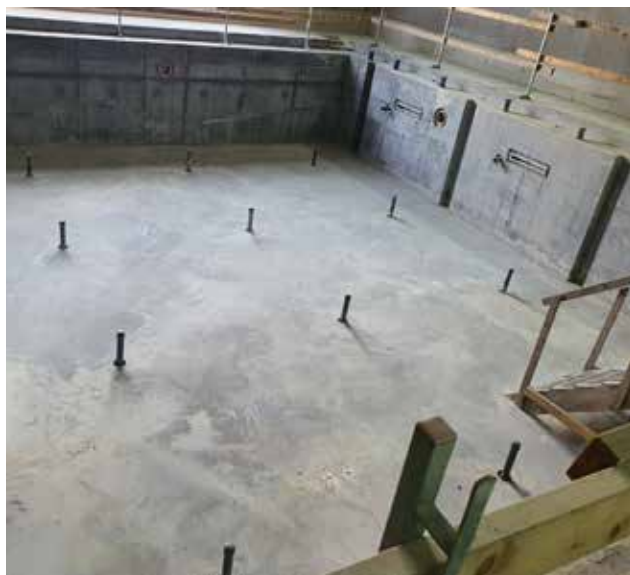
Vid nygjutna och prefabricerade konstruktioner bör ytans hållfasthet och porbildning kontrolleras.
