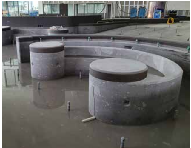
Betongpool – strukturell byggnation.
