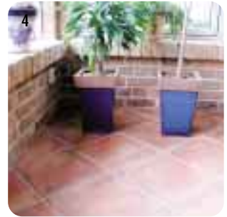
4 Montera värmegolvet eller plattsatt direkt.
