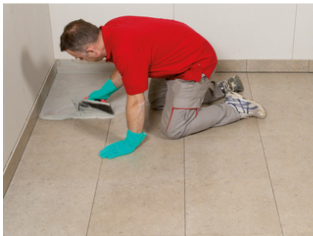
12) När den keramiska beläggningen har blivit gångbar och fogbar kan den fogas med exempelvis Sopro DF 10 ® Flexibel designfog.
