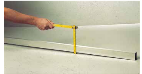
Kontrollera att inga svackor eller bulor förekommer innan tätskiktetsduken appliceras.
