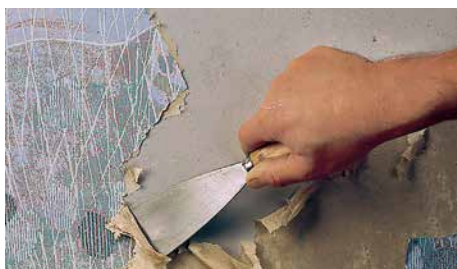
Befintliga ytskikt skall avlägsnas.
