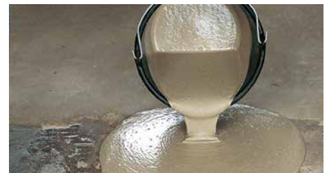
Avjämning utförs med Sopro VS 582.
